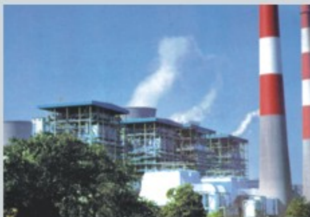
■ 无烟煤锅炉 Snthracite Boiler
